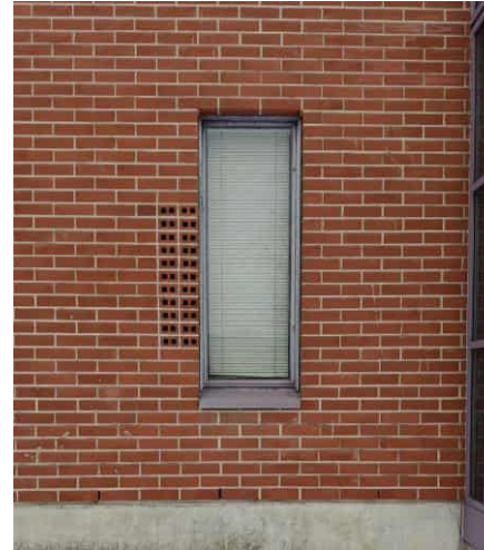
Kuva 33. Toistuva ikkunatyyppe: kiinteä korkea ikkuna, ja sivuosa, jonka edessä on reikätiili.
