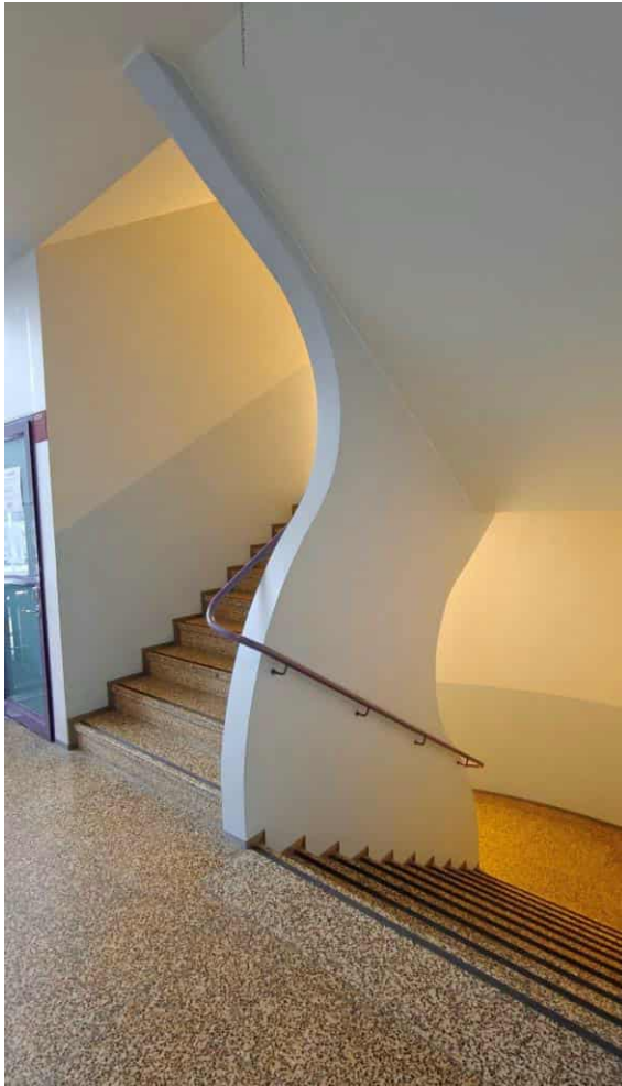
Kuva 72. Pääporras aulan eteläpuolella. Portaiden ja tasanteiden materiaalina on mosaiikkilaatta. Porrassyöksyjen välissä kulkee kantava seinä, jonka reunat on muotoiltu loivasti pyöristetyiksi.
