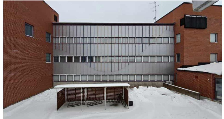
Kuva 40. Itäisen sisäpiha saunatilojen terassilta katsottuna. Pitkän siiven seinäpinnat ovat peltikaseteilla verhoiltuja. Niiden takana on toimisto- ja kokoustiloja.
