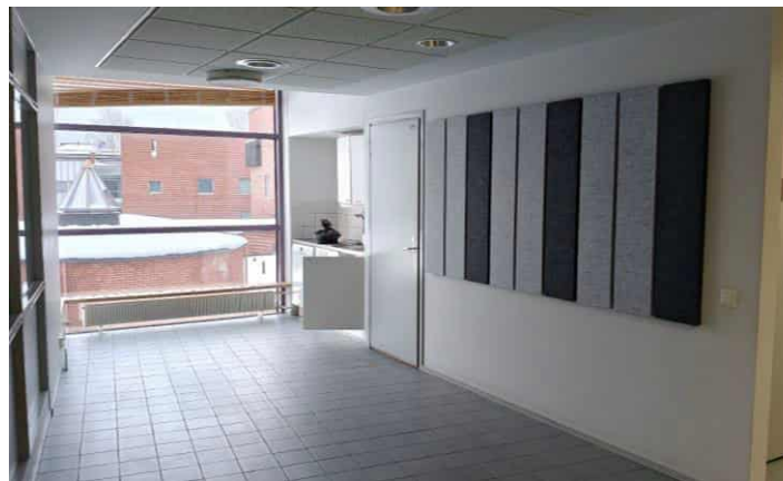
Kuva 67. 3. kerroksen kahvio A322. Kahvioissa lattiapinta on 20 x 20 cm keraaminen laatta. Oikealla keittokomero, jossa kalusteet on uusittu 2020-luvulla. Taustalla kahvion lasiseinä, jossa on koivupintaisia sälekaihtimia, tietävästi alkuperäisiä.
