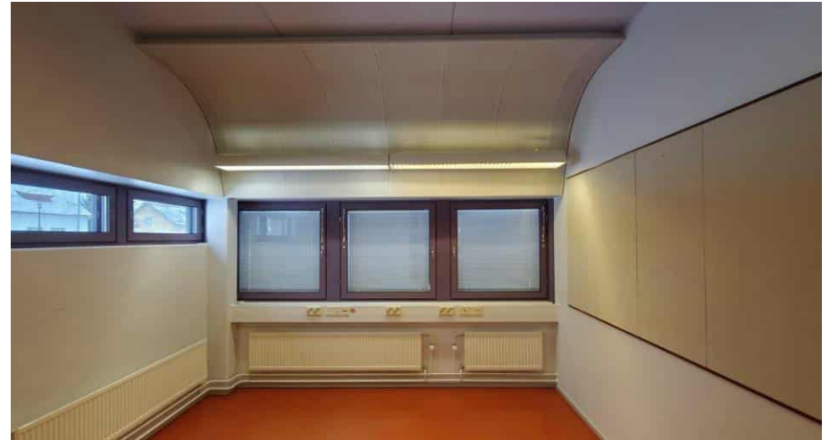
Kuva 53. Rakennuksen luoteiskulman tila A106 sisäpihan puolella. Ikkunatyyppi ja kaarevat alumiinikasetit ovat tilatyypille ominaisia.
